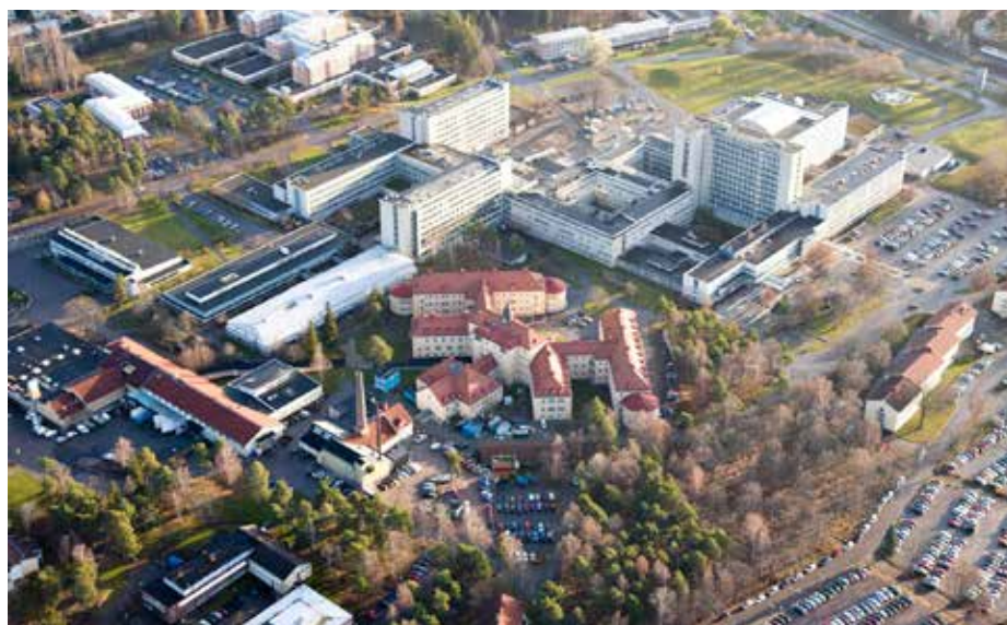
Västmanlands sjukhus Västerås. Reumatologmottagningen finns i den korta enplansbyggnaden mitt för det gamla lasarettet, som ses mitt i bilden. Foto: Landstinget Västmanland.
