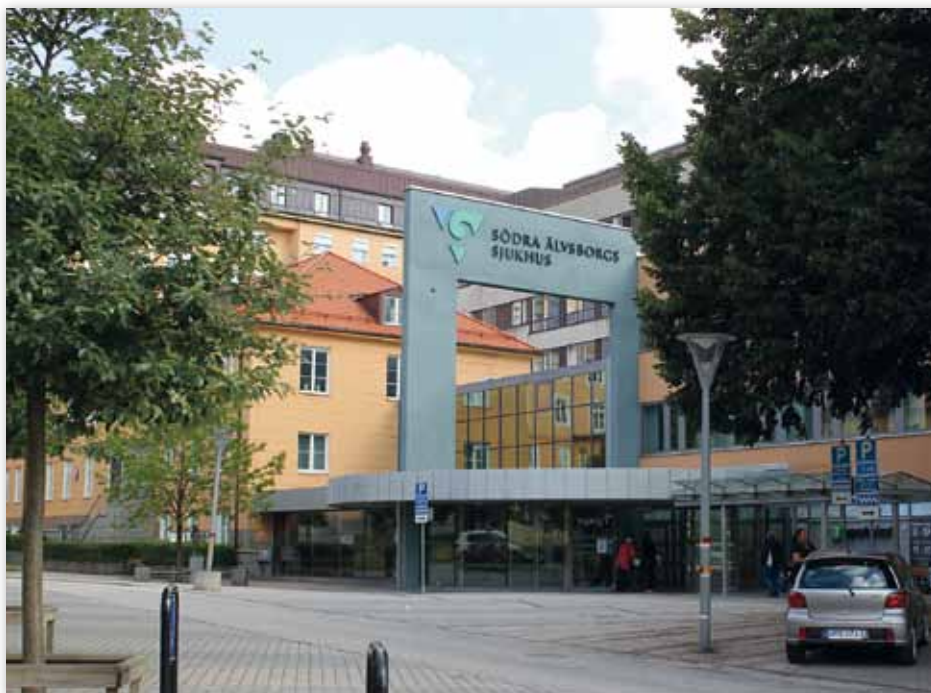
Huvudentrén till Södra Älvsborgs Sjukhus i Borås. Foto: Bengt Lindell.
